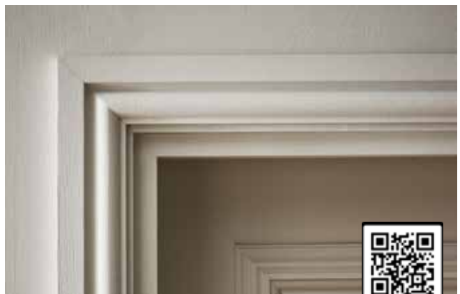
FIT DOOR ARCHITRAVE
